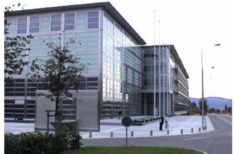
Chemiegebäude auf dem Hönggerberg
